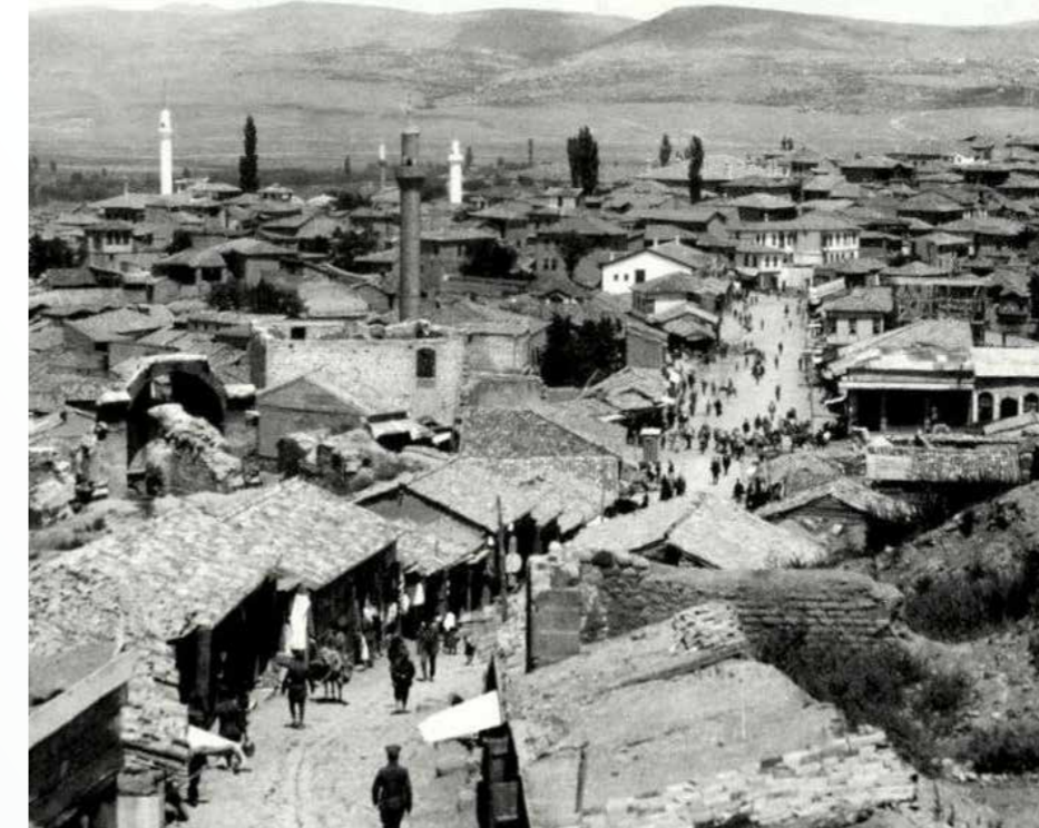
Şekil 4. 1929 Yangını Öncesinde Hacıdoğan Mahallesi'ne Çıkrıkçılar Yokuşundan Bakış Kaynak: Mehmet Tunçer Arşivi
